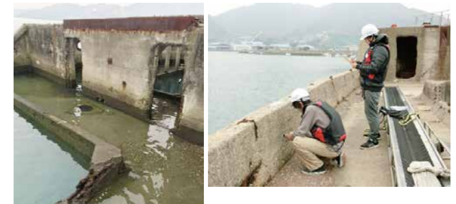
昭和19年に建造され、現存しているコンクリート船の強度調査等を実施。(建築学会大会にて報告)
