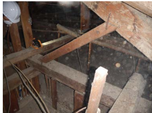
昭和初期の木造校舎の小屋裏調査
